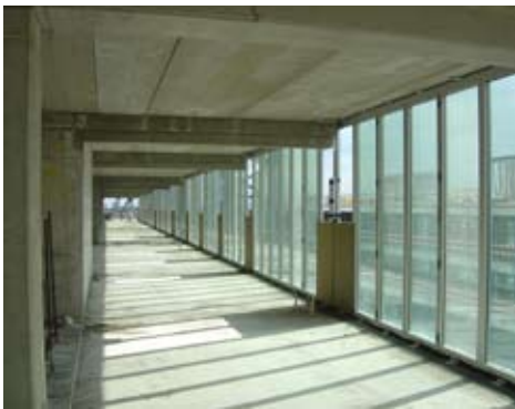
flexibele indeling door open constructie
